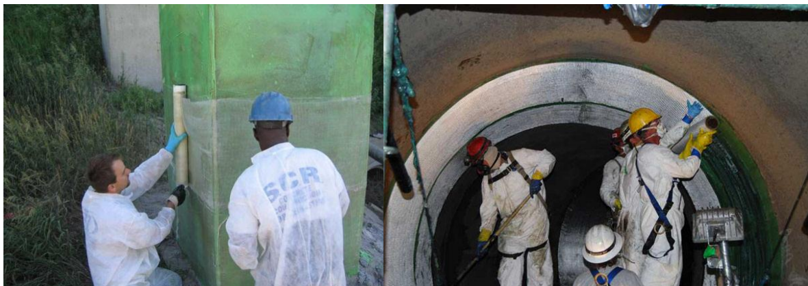
Figura 2.11 – Reforço de pilares e condutas com fibras de vidro
