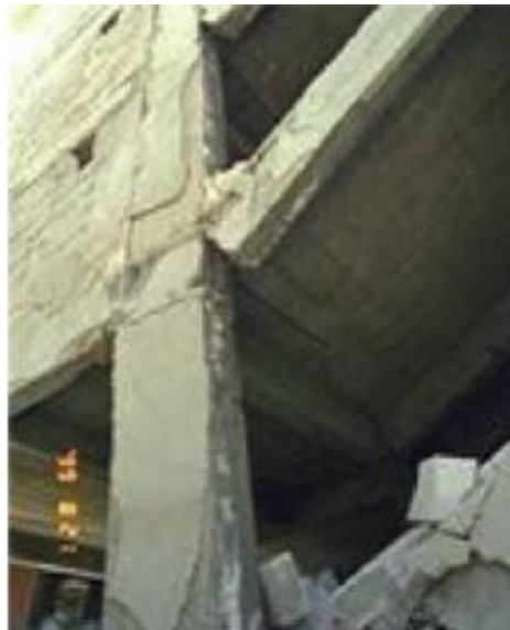
Figura 2.13 – Vigas com comportamento frágil
