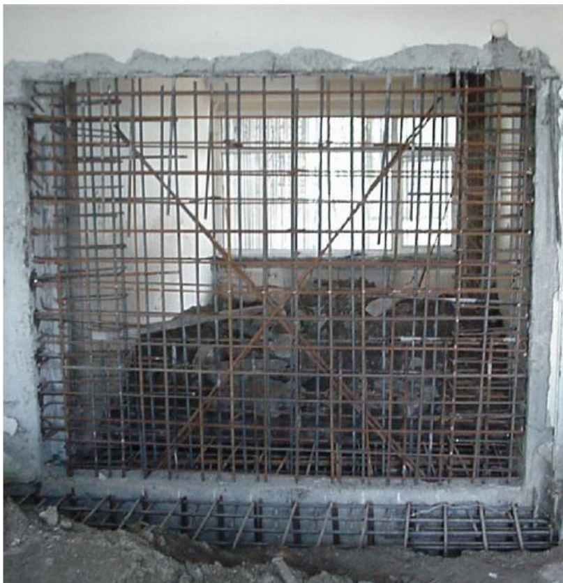
Figura 2.1 – Adição de paredes resistentes de betão armado
