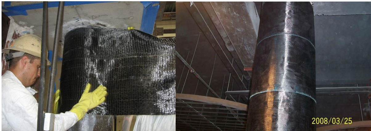
Figura 2.9 – Reforço de pilares de aço e betão com manta de fibra de carbono (CFRP)
