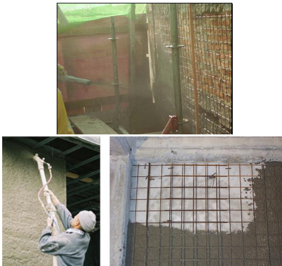
Figura 2.5 – Aplicação de betão projetado
