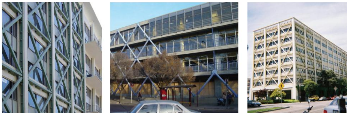
Figura 2.2 – Sistemas de contraventamento metálico como reforço de edifícios existentes
