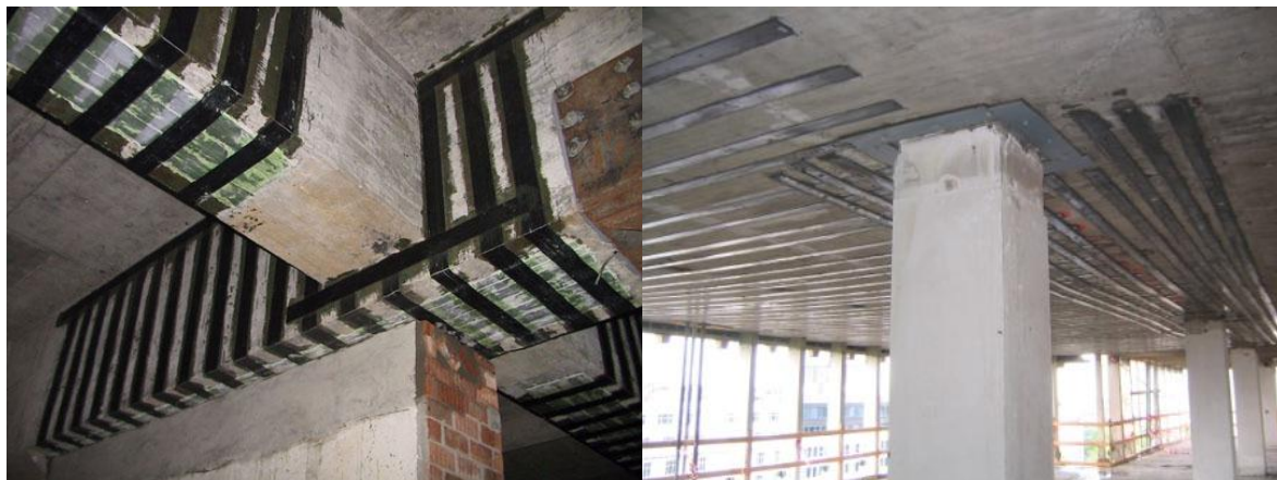
Figura 2.10 – Reforço de uma viga e laje com laminados de carbono
