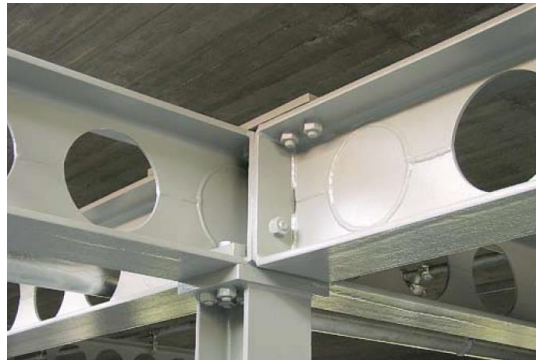
Figura 18. Preenchimento da abertura com discos de aço soldados. Fonte: Arcelor Mittal, [5].
