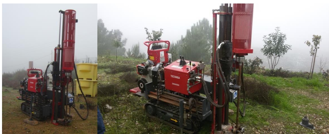
Figura 5 – Equipamento de ensaio posicionado no local do ensaio DSPH1.
