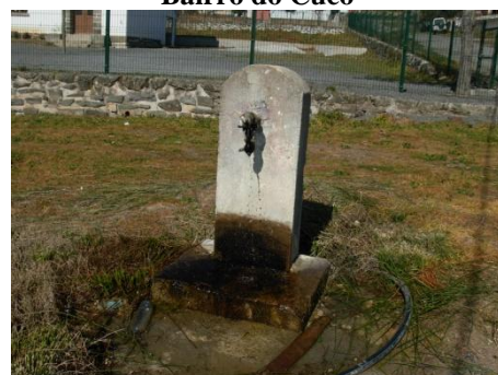
Torneira 1 Junto à Escola Primária
