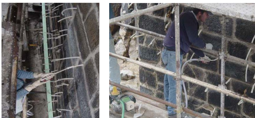
(a) (b) Figura 1 – (a) Preparação da parede de cantaria; (b) Processo de injeção sob pressão.
