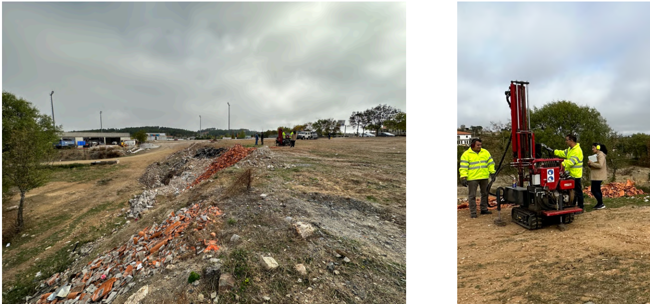
Figura 2 – Local de realização dos ensaios e equipamento de perfuração.
