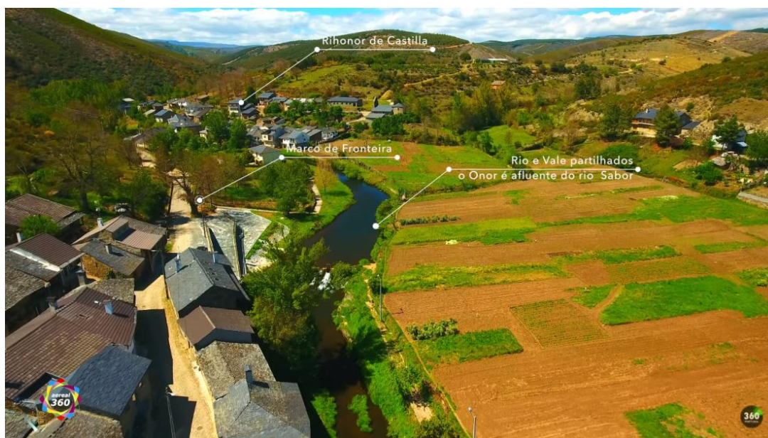
Figura 3: Vista Aérea Rio de Onor
