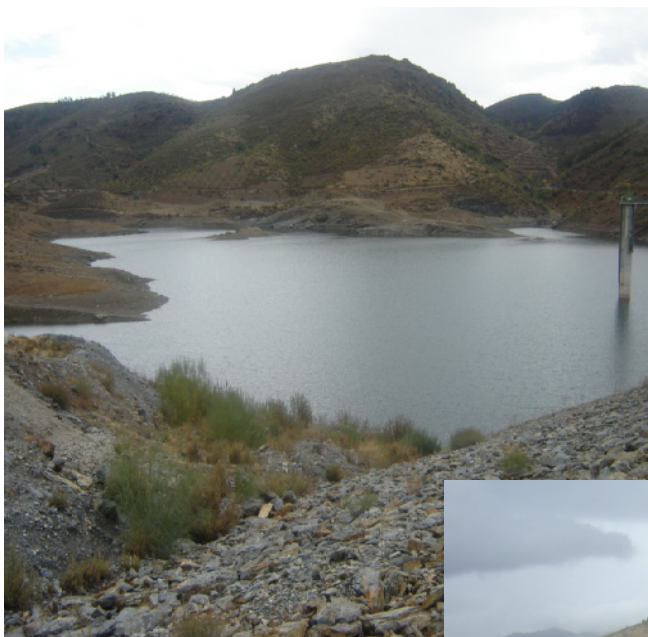
Figura 15 - Vista da Barragem do Salgueiro
