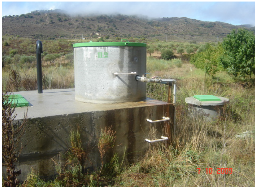
Figura 23 - Hidrante com ventosa e descarga de fundo
