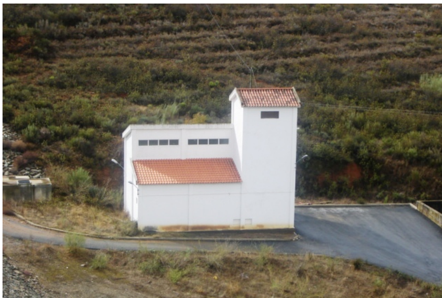
Figura 16 - Estação elevatória de santa Justa
