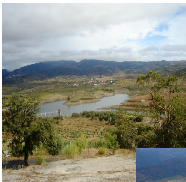
Figura 14 - Vista da Barragem de Santa Justa
