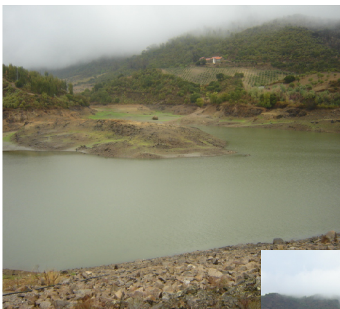
Figura 13 - Vista da Barragem da Burga
