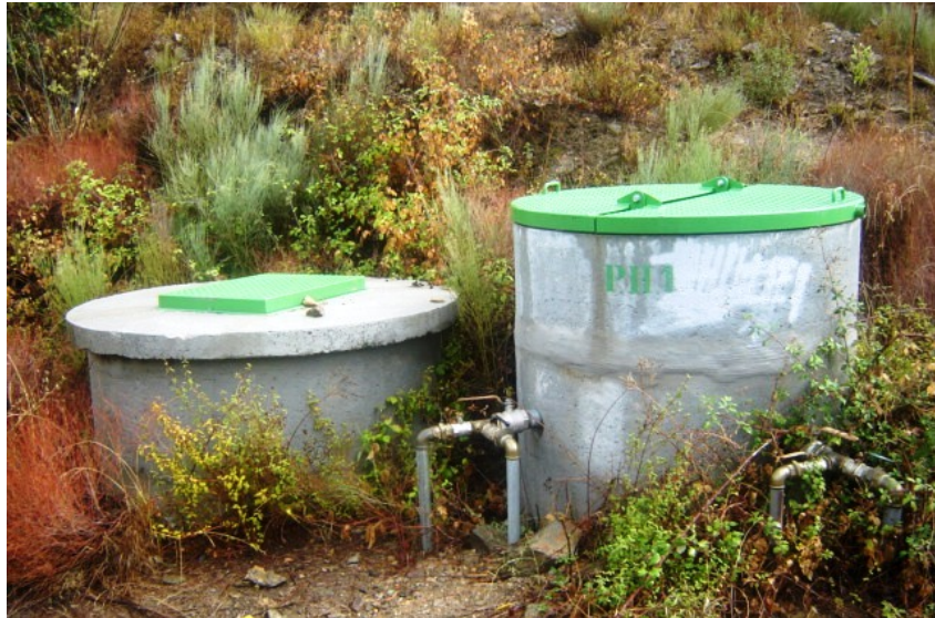
Figura 22 - Hidrante com ventosa
