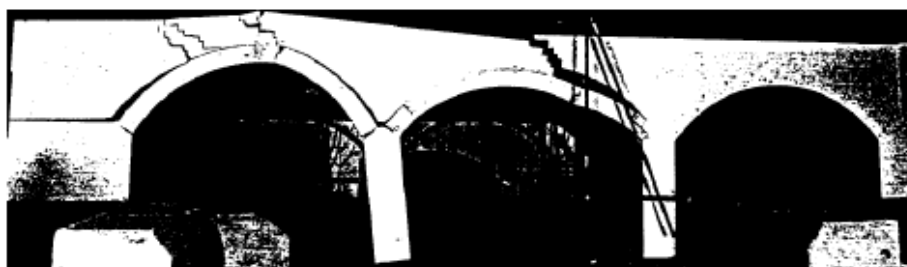
Figura 18 – Danos estruturais do modo de falha multi-arco de 7 rótulas [Costa, 2009]
