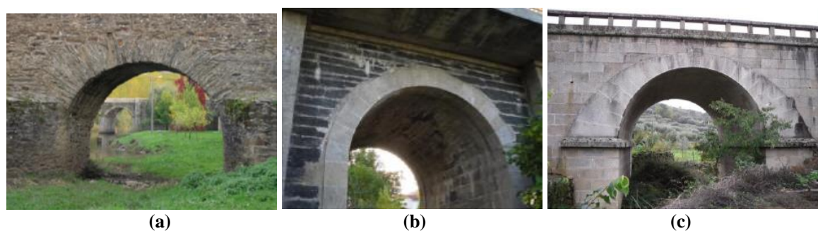
Figura 23 - Espessuras dos arcos em pontes da região de Bragança: (a) espessura irregular; (b) espessura constante; (c) espessura variável. [Jesus, 2013]
