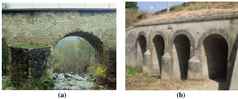
Figura 24 - Talha-mares em pontes da região de Bragança: (a) Talha-mares robustos e triangulares; (b) Talha-mares menor e mais arredondado [Jesus, 2013]
