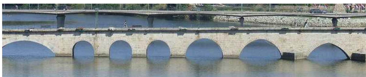
Figura 5 - Ponte Velha em Mirandela [Costa, 2009]
