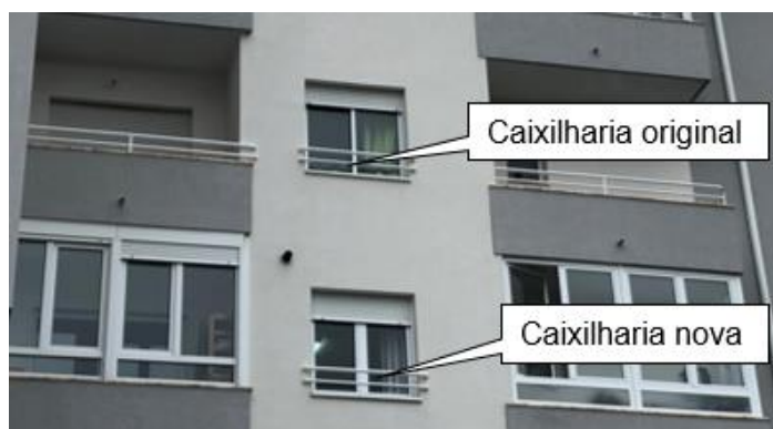
Figura 7.20 - Caixilharias originais e novas do edifício R.
