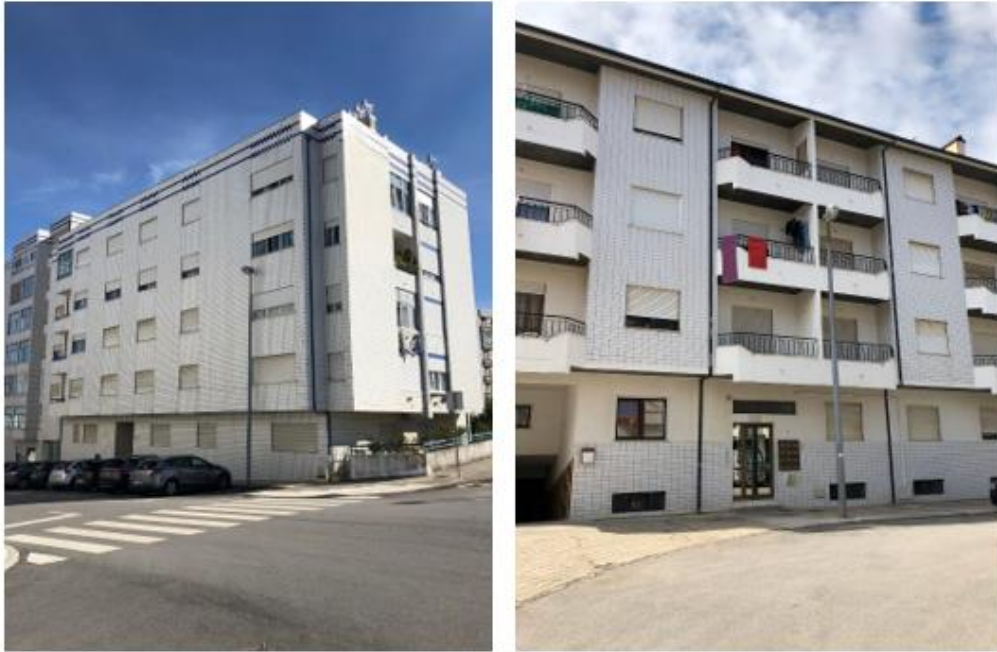
Figura 7.31 - Edifícios K (Esquerda) e T (Direita).
