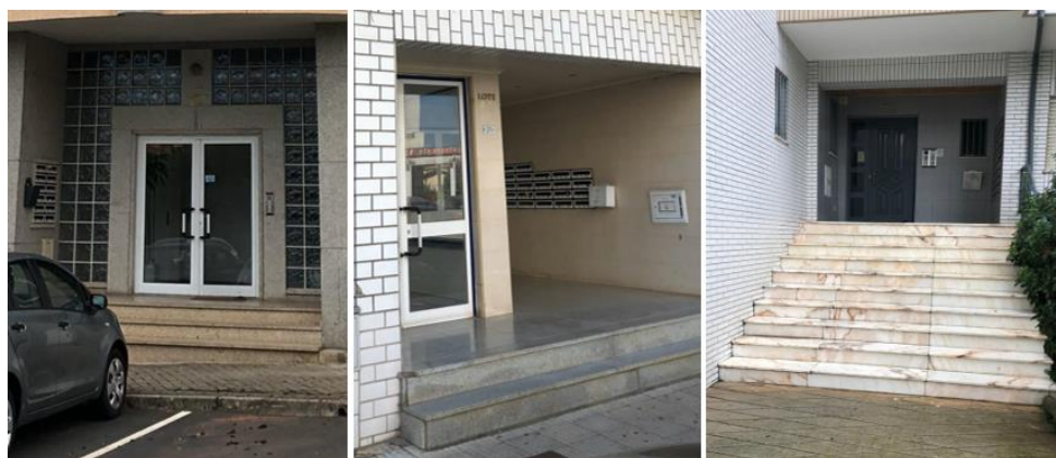
Figura 7.37 - Exemplos de escadas de entrada. Edifícios “G”, “I” e “S”, respectivamente.
