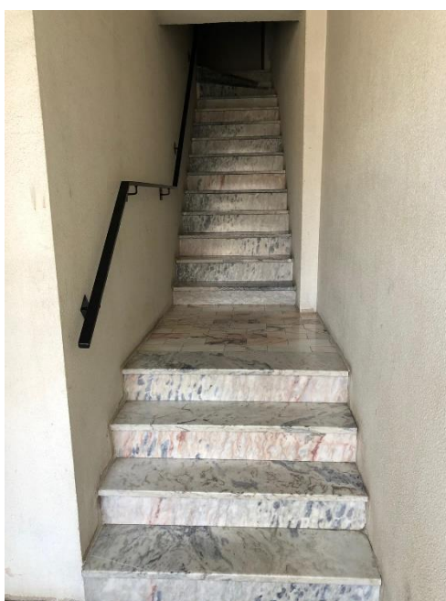
Figura 7.35 - Escada de acesso ao edifício E.
