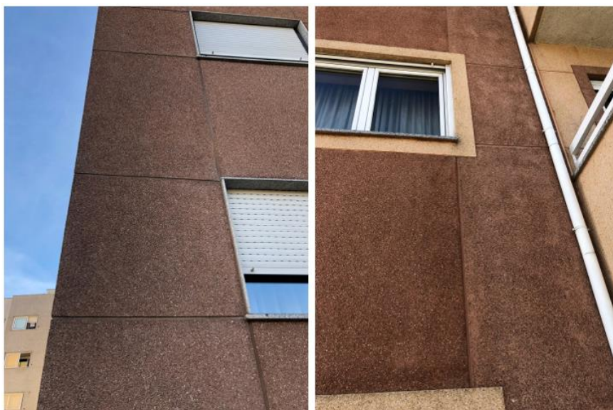
Figura 7.42 - Exemplos de reboco monomassa (edifícios "H" e "L").
