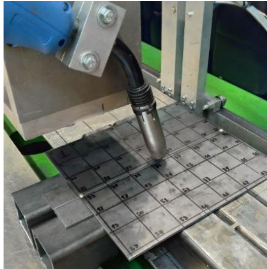
Figura 45: Arranjo sem restrições de movimento durante o processo de soldadura em juntas de topo
