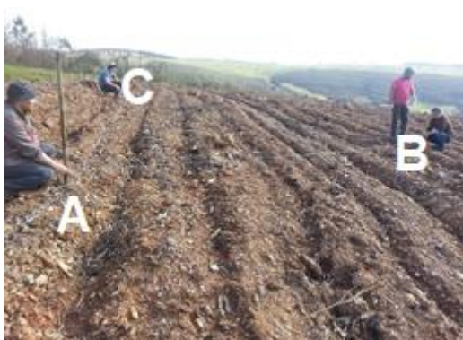
Figura 3. Instalação dos souts: Piquetagem
