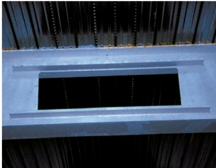
Figura 2.10: Enrijecedores laterais no entorno de uma abertura alongada, [15].
