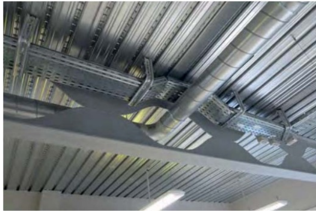
Figura 2.7: Viga alveolar com abertura senoidal, [9].
