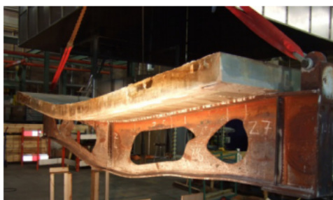
(a) Viga alveolar sem proteção
