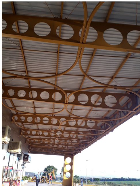
Figura 2.6: Viga celular em estrutura de paragem de autocarros.
