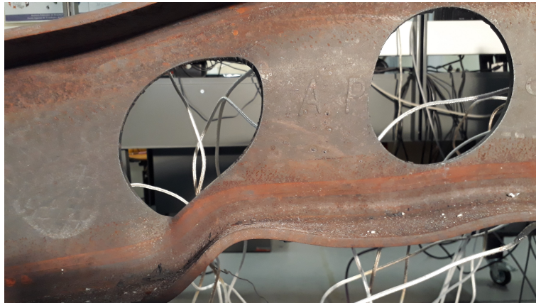
Figura 4.19: Deformação plástica na Viga B5.
