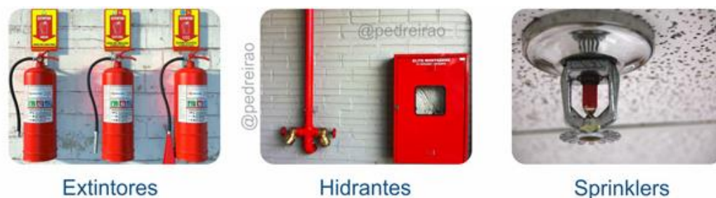
Figura 2 - Sistemas de proteção ativa contra incêndio, [9].
