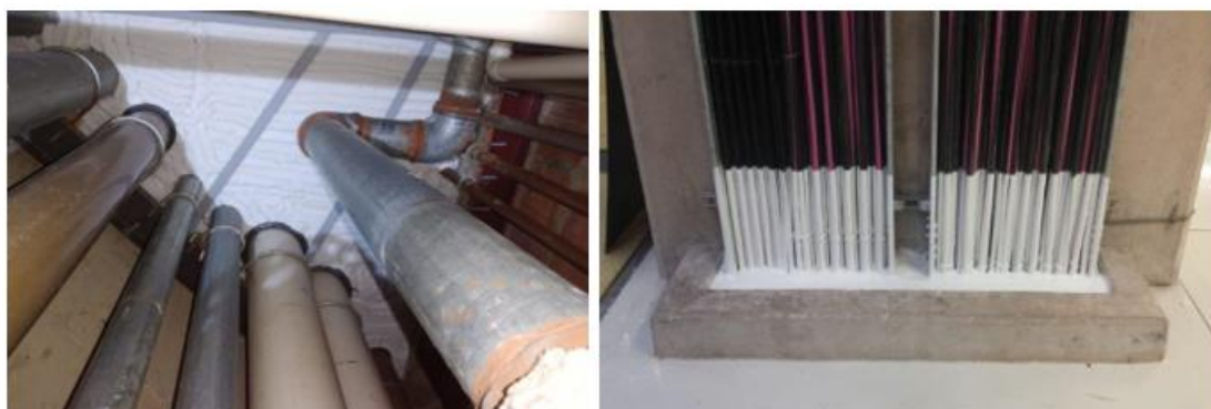
Figura 3 – Vedação de dutos e tubulações entre andares,[10].
