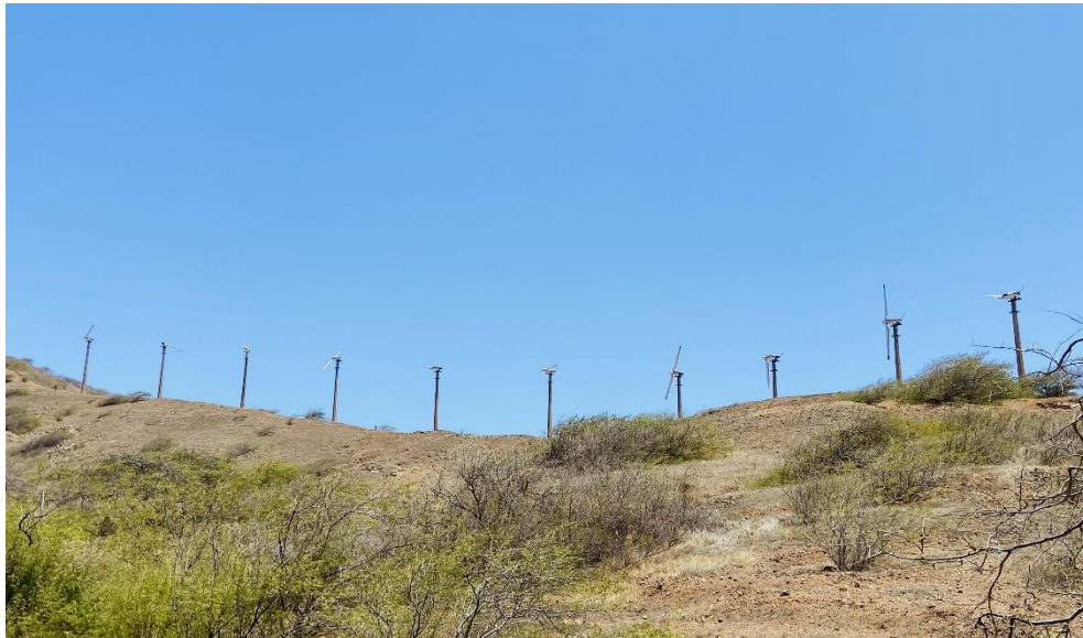
Figura 21-Parque eólico da Ribeira de Vinha (Vista Frontal)
