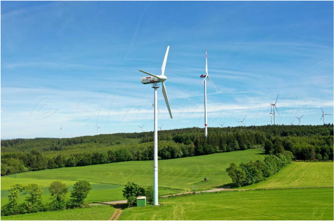
Figura 38-Enercon E-33 (Vista Completa) [38]
