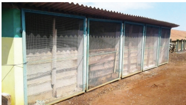
FIGURA 4.60 – Instalações de compostagem.
