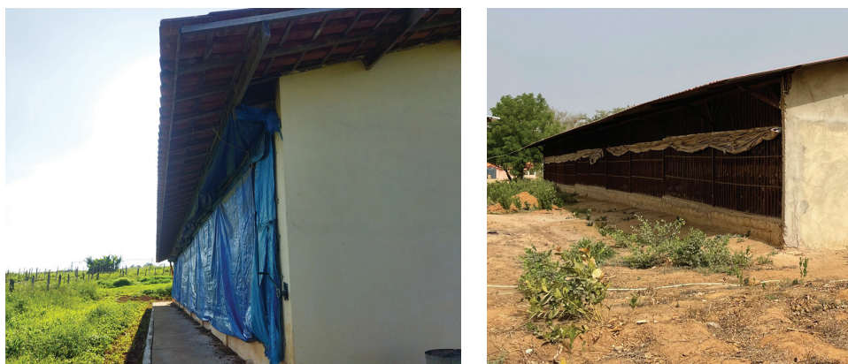
FIGURA 4.16 - Quando está frio, as cortinas abrem-se de cima para baixo (a) e quando está calor, estas são abertas de baixo para cima (b).
