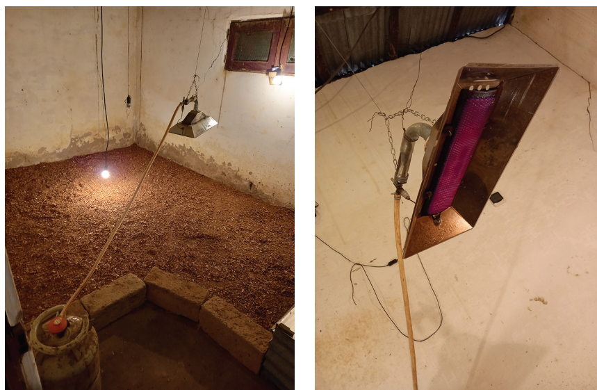
FIGURA 4.49 – Aquecedor a gás com placa cerâmica.
