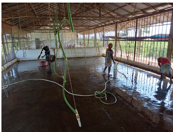
FIGURA 4.11 - O piso em cimento facilita os procedimentos de higienização.
