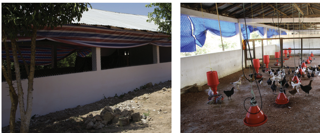
FIGURA 4.13 - Pavilhão para aves com telhados prolongados, alpendre e cortinas.
