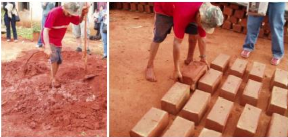
Figura 2- A preparação do solo e a moldagem de adobes em Bichinho, Estado de Minas Gerais Fonte: [5]
