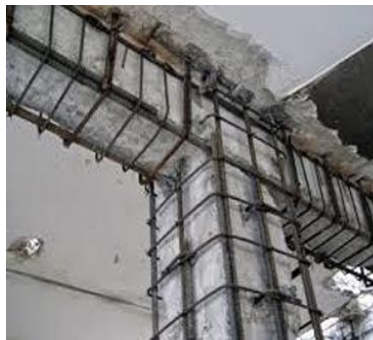
Figura 54 - Encamisamento de nó de ligação viga/pilar (17).
