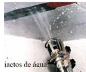
Figura 90 - Limpeza da superfície com jatos de água (17).
