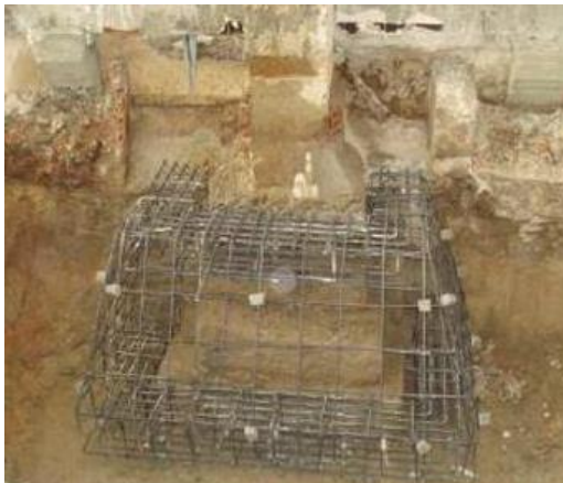
b.1) - Colocação de armaduras de cintagem
