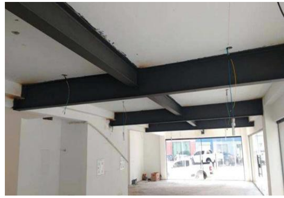
Figura 116 - Reforço de laje com introdução de perfis metálicos (20).
