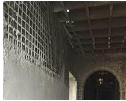
Figura 56 - Encamisamento de parede com betão projetado (17).
