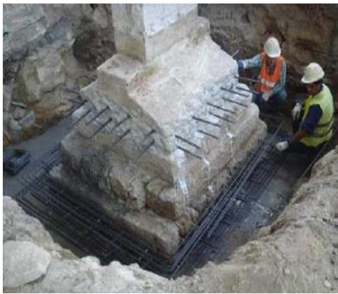
a) - Introdução dos varões nos furos realizados na fundação;
