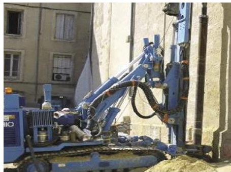
Figura 44 - Equipamento de perfuração para execução de micro-estacas (14).
