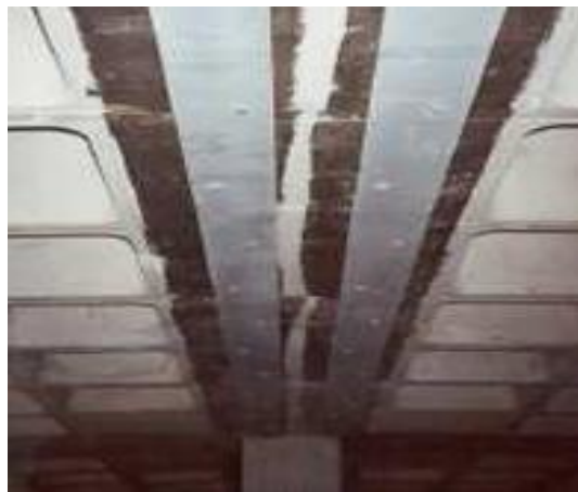
Figura 99 - Reforço de viga nervurada de uma laje fungiforme com colagem de chapas metálicas (17).
