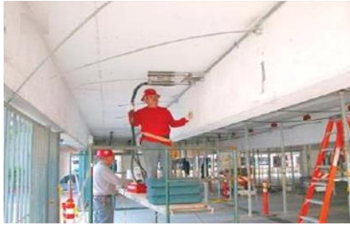
Figura 111 - Operação de tensionamento dos cabos de pré-esforço (22).
