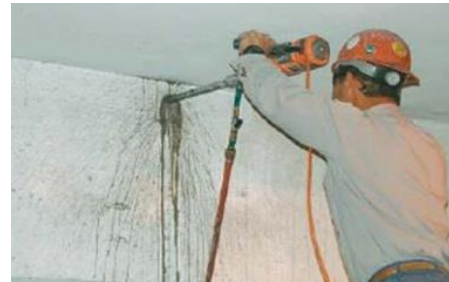
Figura 108 - furação do elemento existente (22).
