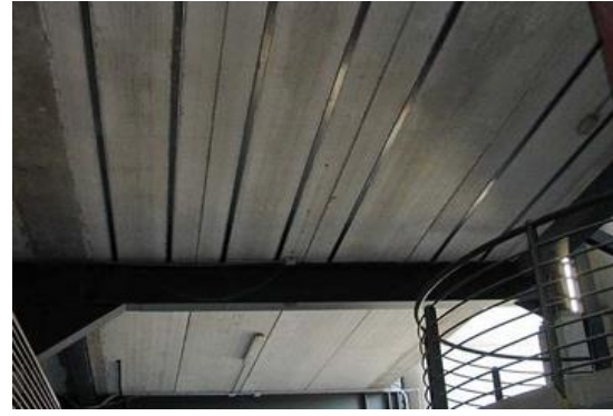
Figura 97 - Reforço de laje com laminado de FRP (20). Figura 98 - Reforço de laje com laminado de FRP (19).
