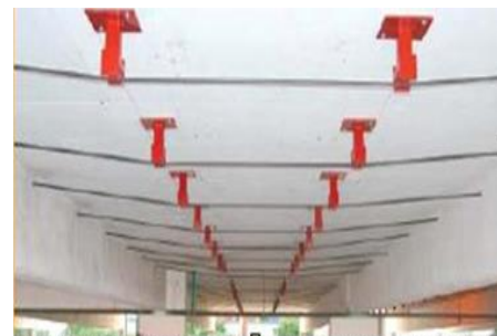
Figura 110 - Estado final do reforço (22).
