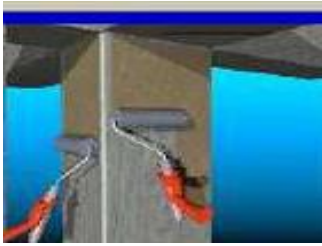
Figura 91 - Aplicação de primário epóxico (17).
