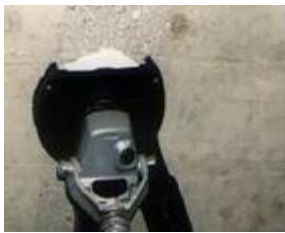
Figura 88 - Preparação da superfície do betão por picagem (17).
