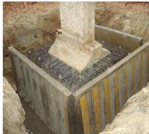
C) - Colocação de cofragem com as dimensões finais do elemento reforçado
