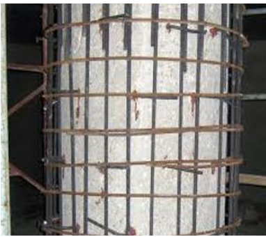
Figura 55 - Encamisamento de pilar (17).
