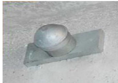
Figura 114 - Pormenor de uma ancoragem com proteção galvanizada (22).
