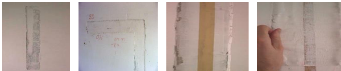
Figura a) Remoção de faixa de revestimento.
