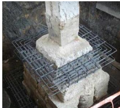
b) - Colocação de armaduras de cintagem
