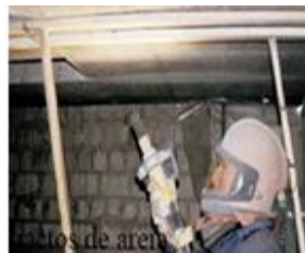
Figura 89 - Preparação da superfície do betão por jato de areia (17).
