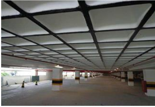
Figura 97 - Reforço de laje com laminado de FRP (20). Figura 98 - Reforço de laje com laminado de FRP (19).
