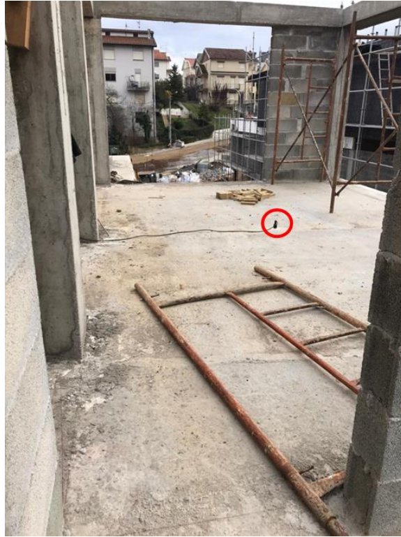
Figura 17 - Foto superior da laje ensaiada com acelerômetro
