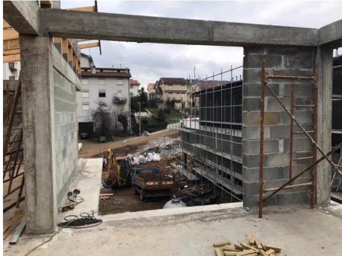
Figura 13 - Vista da obra
