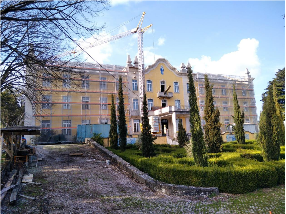
Figura 2 – Vista frontal da edificação.
