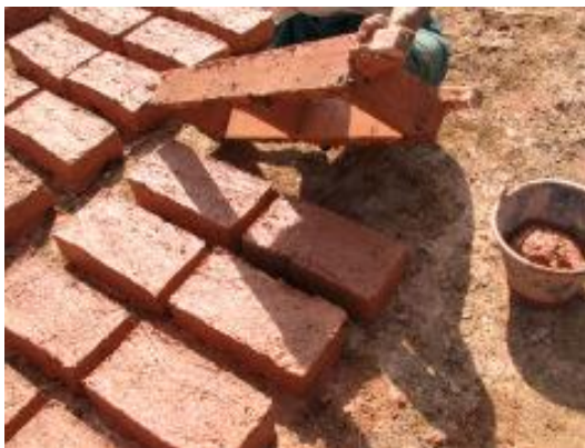
Figura 3 – Desmolde e secagem de blocos de adobe. Fonte: [19].
