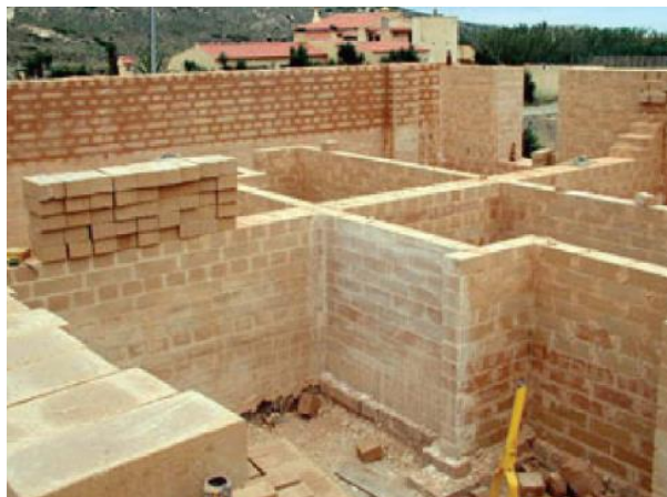
Figura 4 – Residência com alvenarias em BTC, Alentejo, Portugal. Fonte: [2].
