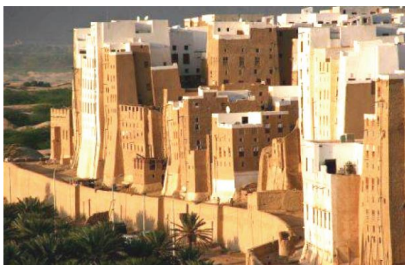
(c) Edifícios feitos em adobe, Shibam, Iémen.
