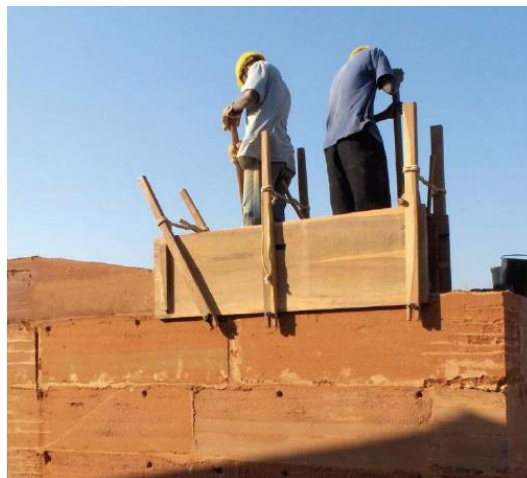
Figura 2 – Construção de parede em taipa. Fonte: [17].
