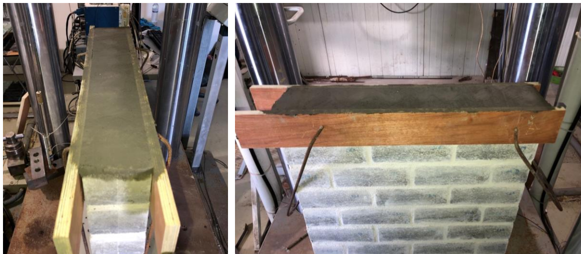
(b) Aplicação e alisamento da argamassa de presa rápida.
