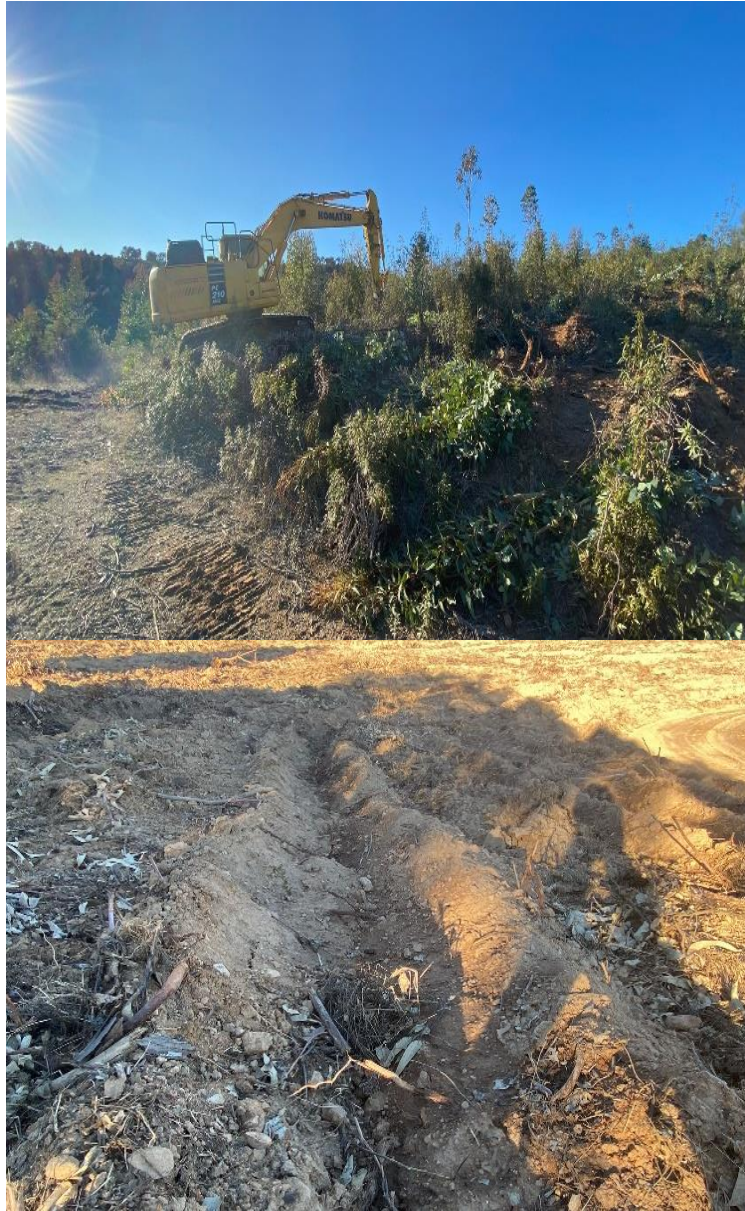
Figura 8- Preparação de terreno (vala e cômodo) na Quinta das Charas (novembro de 2021). Fonte: Fotografia da autora.
