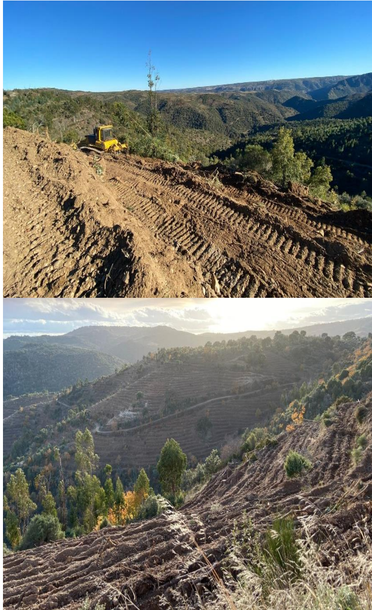
Figura 9- Recuperação de banquetas previamente existentes na Quinta das Charas (novembro de 2022). Fonte: Fotografia da autora.
