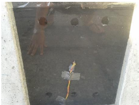
Figura 180 – Aberturas de ventilação
