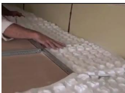
Figura 13 – Aplicação da manta num teto falso na horizontal [6]
