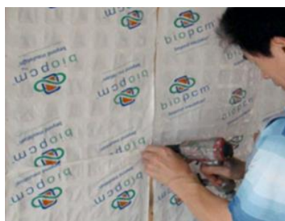
Figura 14 - Aplicação da manta na vertical [6]
