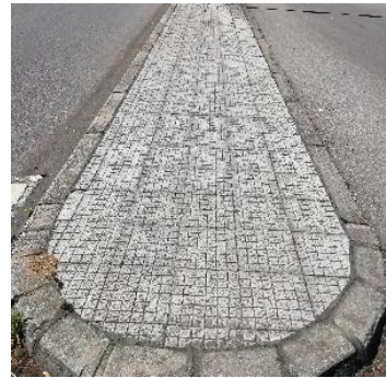
Figura 9- Pavimento quadrado de cimento
