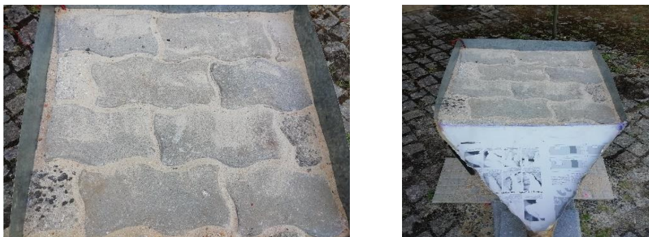
Figura 60- Pavimento permeável construído com blocos de cimento “mapa de Portugal”
