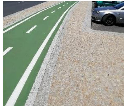
Figura 11- Pavimento cubos granito pequeno
