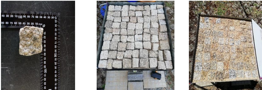
Figura 48- Pavimento permeável construído com cubos de granito pequenos
