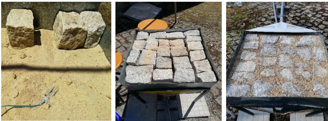
Figura 51- Pavimento permeável construído com cubos de granito grandes
