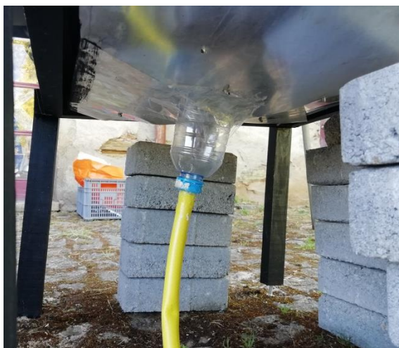
Figura 37- Caixa colectora da água de infiltração
