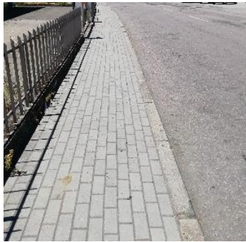
Figura 8- Pavimento bloco retangular
