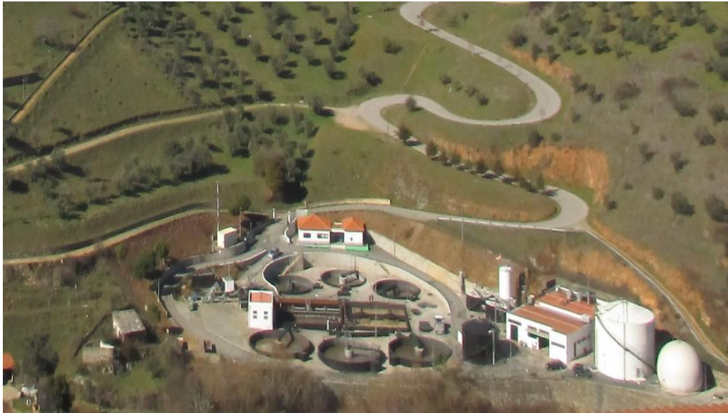
Figura 6- Estação de Tratamento de Águas Residuais de Bragança
