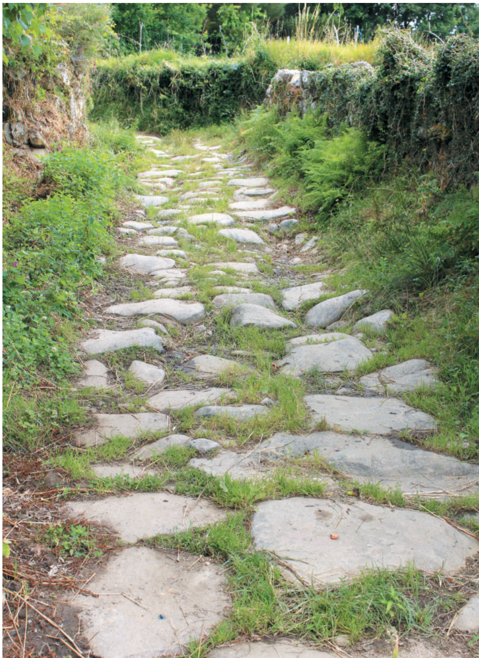
Um trecho da calçada lajeada de Benagouro, na estrada medieval para Chaves
