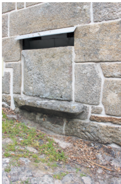
Janela viária, agora emparedada, numa casa de 1764. Desenhos da respectiva estrutura original e de uma inscrição existente num lintel da mesma fachada
