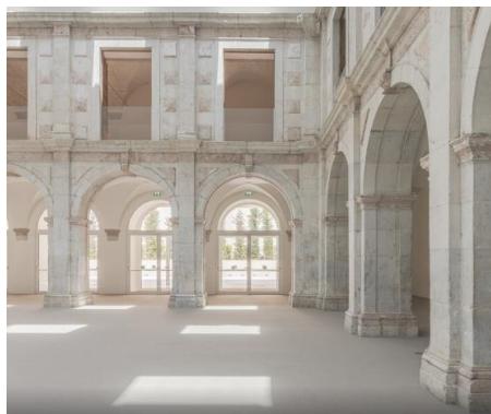
Figura 21 - Exemplo de Reutilização de Edifício Existente
