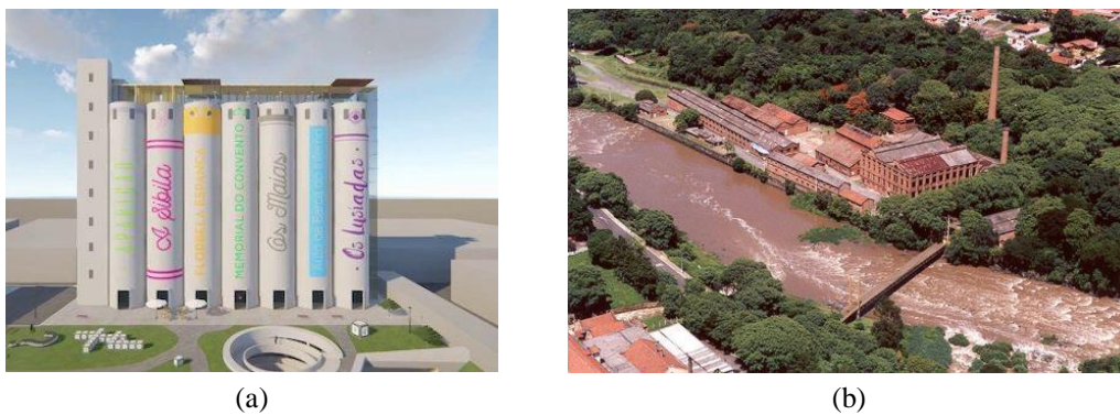
Figura 19 - Exemplos de Reutilização de Estruturas Existentes como Estratégia de Redução de Consumo de Recursos e Valorização do Edificado.
