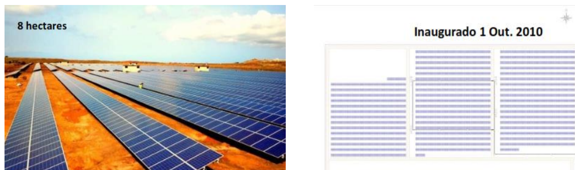
Figura 22 - Parque fotovoltaico na ilha do Sal [14].
