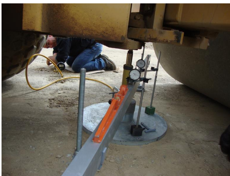
Figura 3-8 - Realização do ensaio de carga em placa no ponto P1.2.
