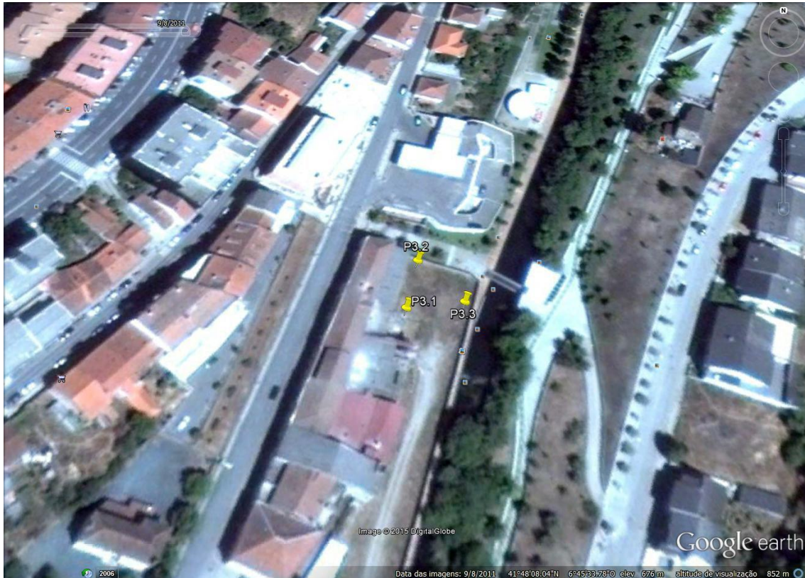
Figura 2-5 - Vista aérea da Zona 3 (foto obtida a partir de Google Earth).
