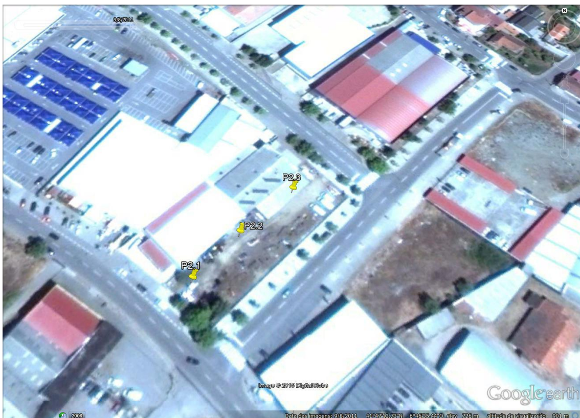
Figura 2-4 - Vista aérea da Zona 2 (foto obtida a partir de Google Earth).
