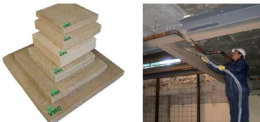
Figura 5- Placas de vermiculite e aplicação de vermiculite por projeção, [19].
