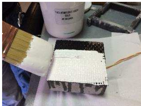
Figura 35 – Pintura com a tinta intumescente.
