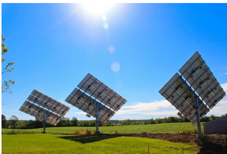
Figura 2.16 - Estrutura seguidor solar de um eixo vertical para painéis solares fotovoltaicos [21]
