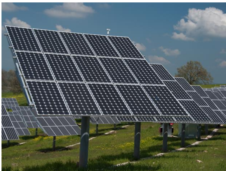
Figura 2.15 - Estrutura seguidor solar de um eixo vertical para painéis solares fotovoltaicos [20]
