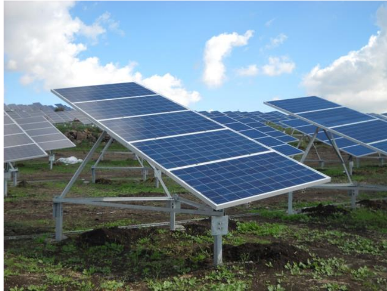
Figura 2.14 - Estrutura seguidor solar de um eixo inclinado para painéis solares fotovoltaicos [20]
