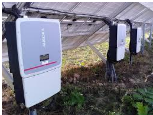
Figura 3.4 - Inversor String Power-One , utilizado nos estudos [27]
