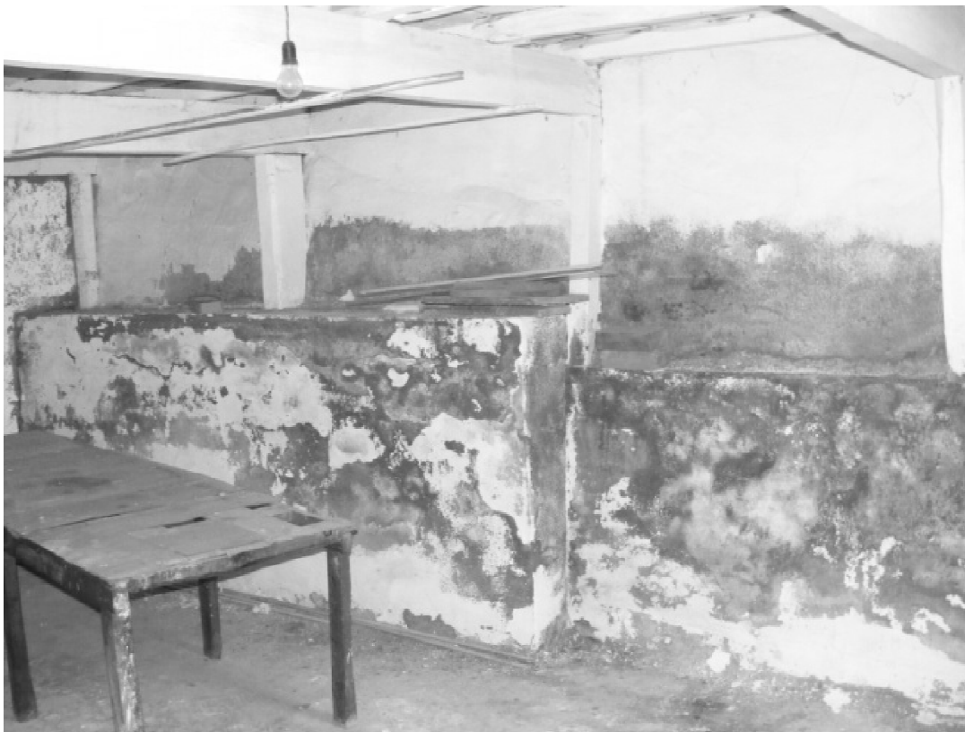
Figura 2.4 – Vista do piso térreo, das paredes e do piso do andar
