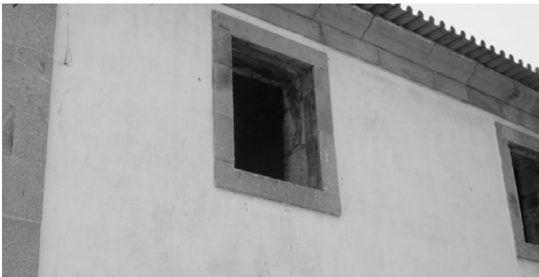
Figura 2.3 – Espessura das paredes exteriores.
