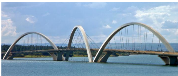
Figura 3- Ponte com estrutura em arco (Ponte Juscelino Kubitschek Brasília), [3]
