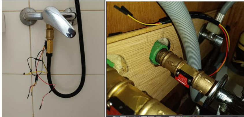
Figura 22: Instalação dos sensores
