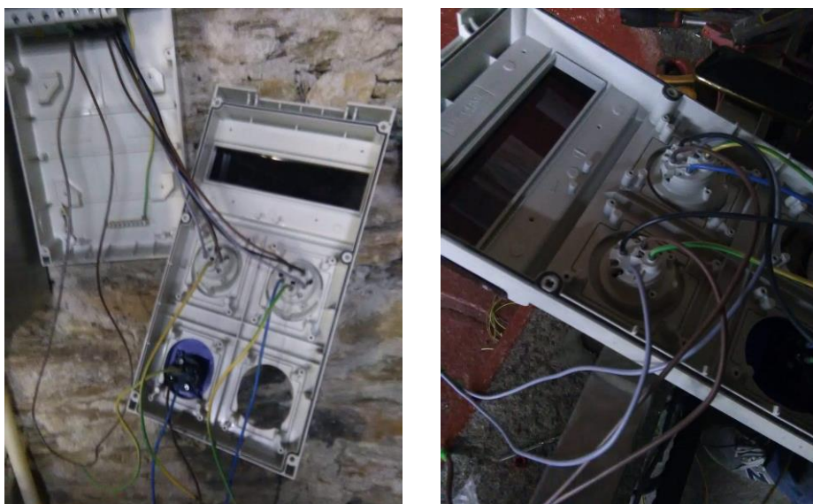
Figura 74 - Montagem e ligações das tomadas trifásicas e monofásicas no quadro elétrico.
