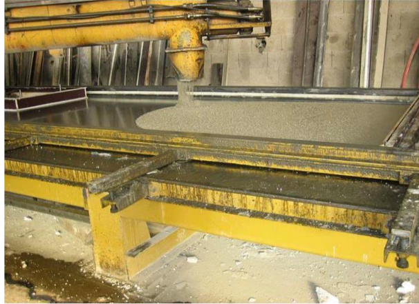
Figura 14 - Betonagem da camada inferior (José Rui Pinto, 2021)
