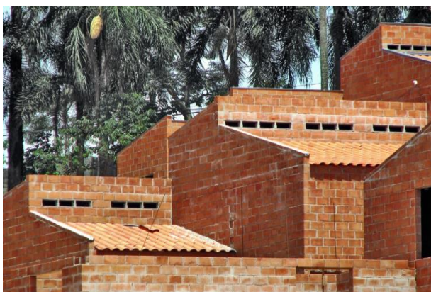
Figura 2 - Fachada em alvenaria (hometeka 2014)
