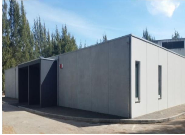
Figura 21- Painéis com texturas rústicas (Empresa FARCIMAR)
