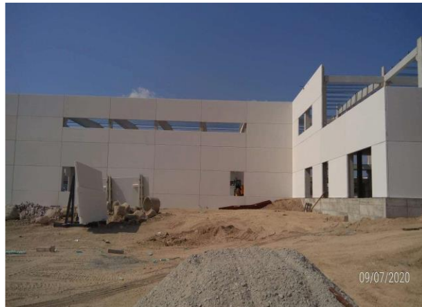
Figura 19 - Montagem dos painéis (José Rui Pinto, 2021)
