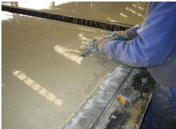
Figura 16 - Regularização do betão (José Rui Pinto, 2021)
