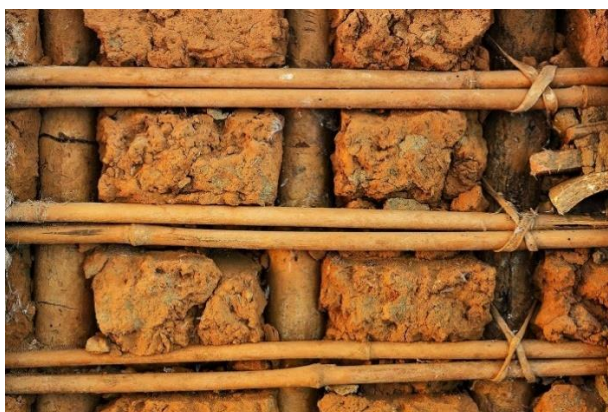
Figura 1 - Paredes de adobe - Foto de Elio Moroni Filho
