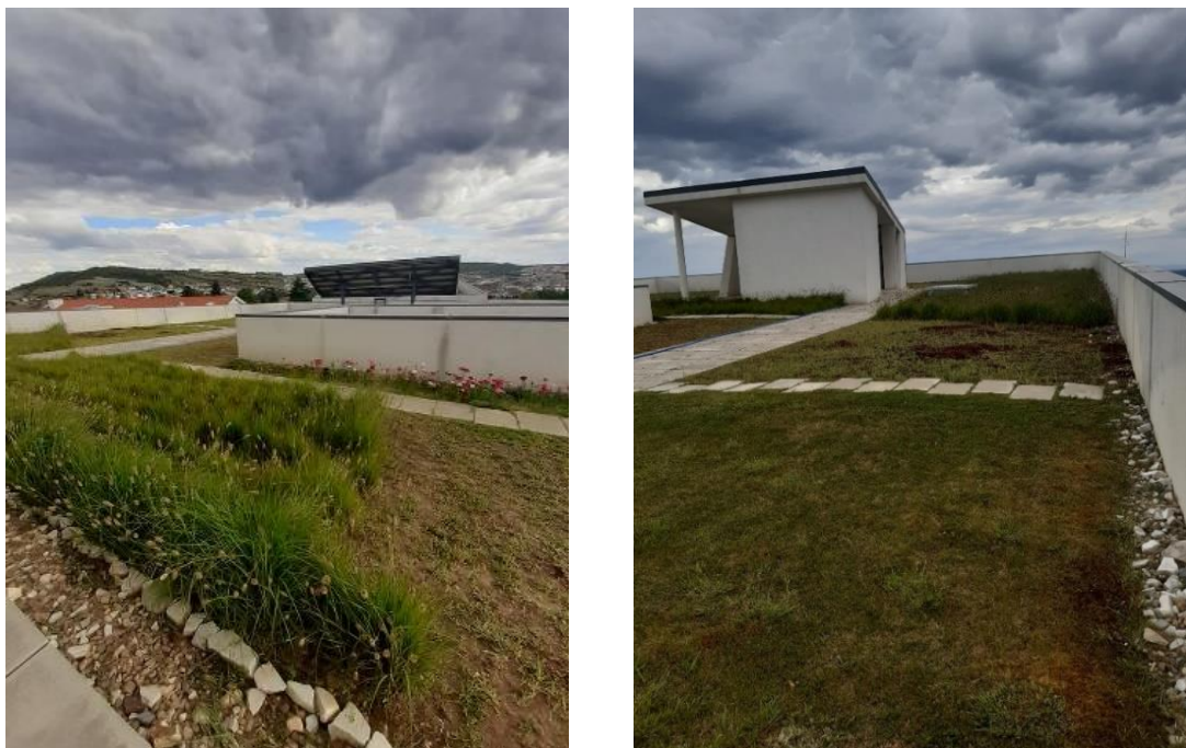
Figura 1.2: Exemplo de cobertura verde no edifício da Câmara Municipal de Bragança
