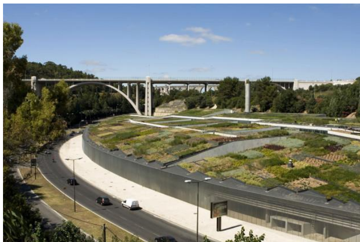
Figura 2.6: Coberturas verdes na ETAR de Alcântara. Disponível em: < http://www.proap.pt/pt-pt/projecto/etar-de-alcantara/ >. Acesso em 04 abril 2022
