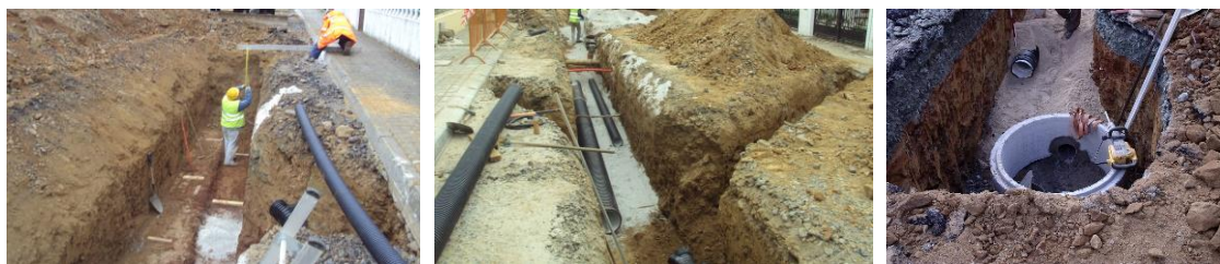
Figura 2.2: Execução de um sistema separativo de drenagem de águas pluviais e residuais
